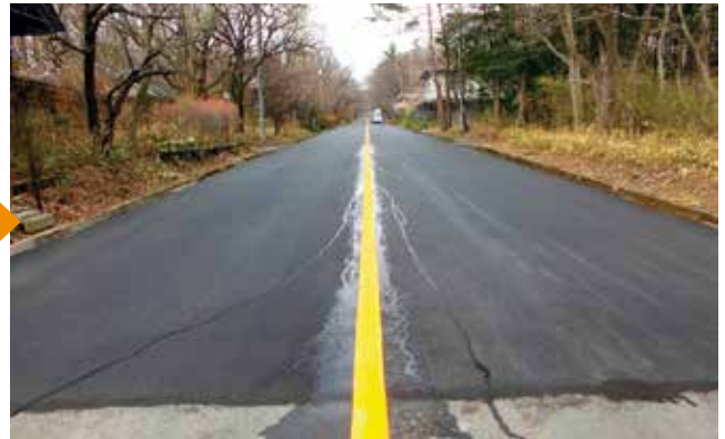
<補修工事後：令和5年4月6日>
