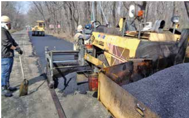
<作業風景：令和5年3月>
