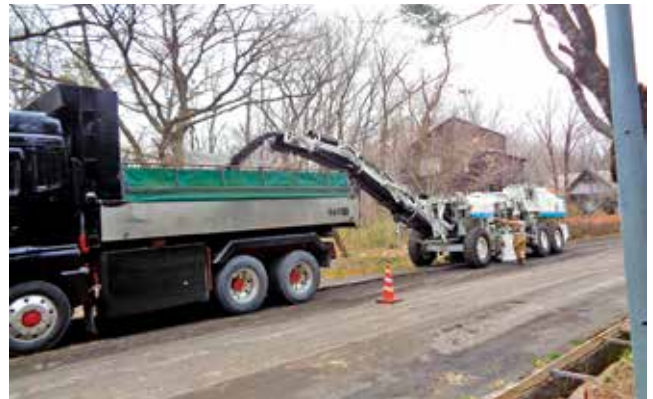
<作業風景：令和5年3月>
