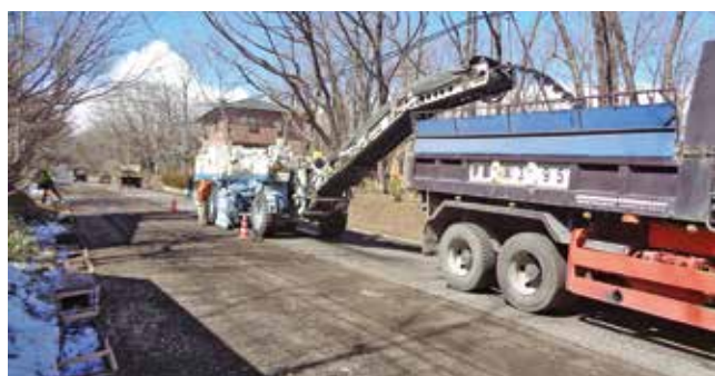
<作業風景 : 令和6年3月>
