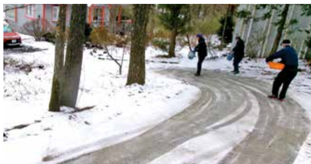
<凍結危険箇所への融雪剤散布 : 令和6年1月>
