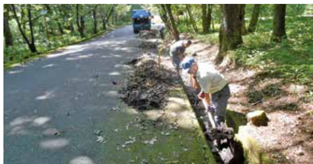
<側溝清掃 : 令和5年8月>
