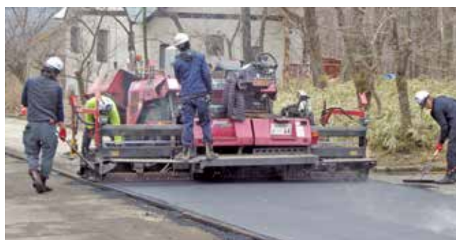
<作業風景 : 令和6年3月>
