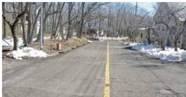
<補修工事前 : 令和6年3月11日>
